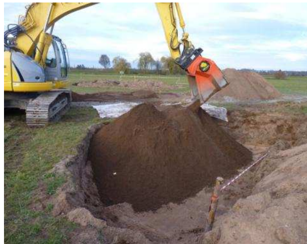
Wiedereinbau der Erde
