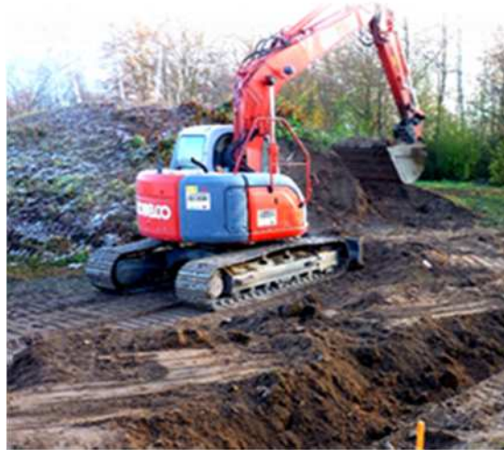
Auftrag der 1. Materialschicht
