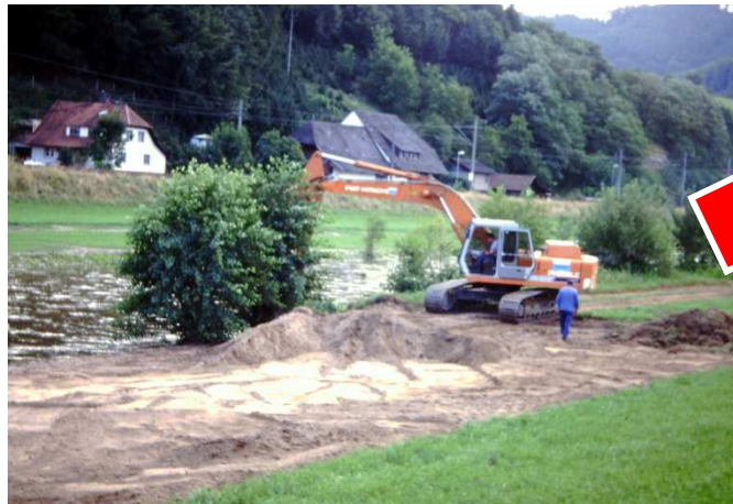
Unterhaltungsmaßnahmen (Sedimenträumung/Vorlandabtrag)
